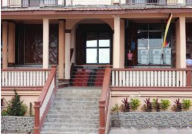
Eingang „Jennabwa Lodge and Restaurant“
